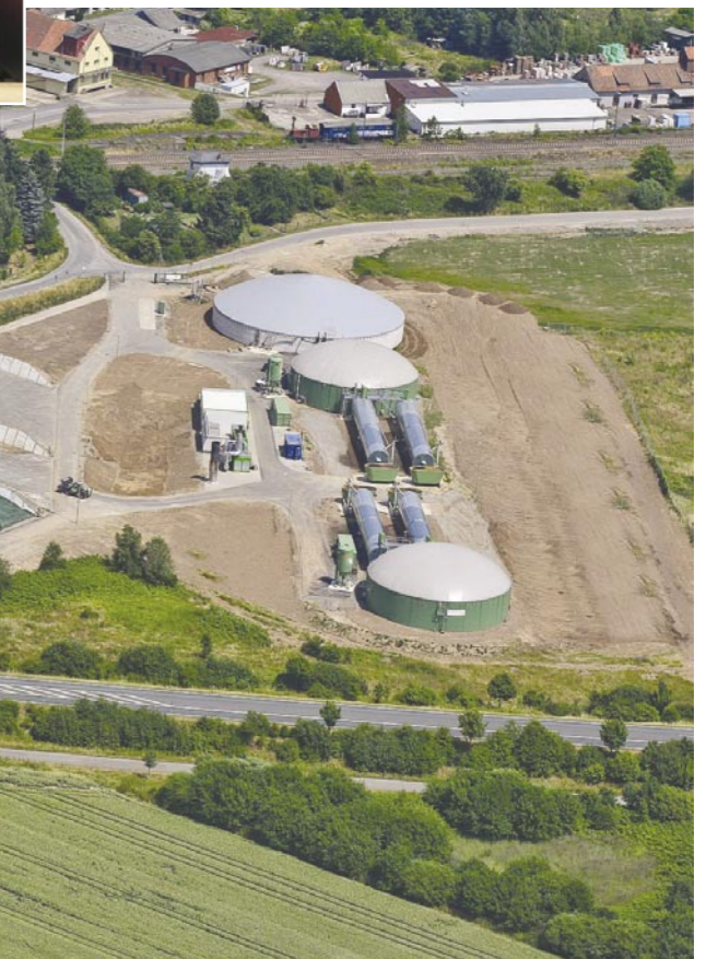
Biogasanlage Hessisch Oldendorf der E.ON Westfalen Weser/Betriebsführung durch die ARCHEA Service GmbH
